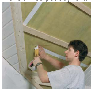
Repararea unei membrane anti-condens cu 186
